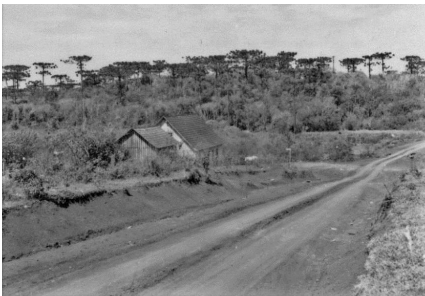
Moradia de colonos, em meio à floresta, sobressaindo à araucária angustifolia .
