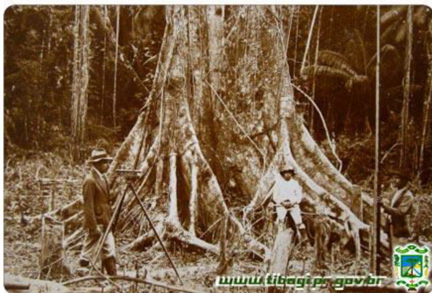
Figura 02: Trabalho de abertura da estrada entre Guarapuava e Campo Mourão.
